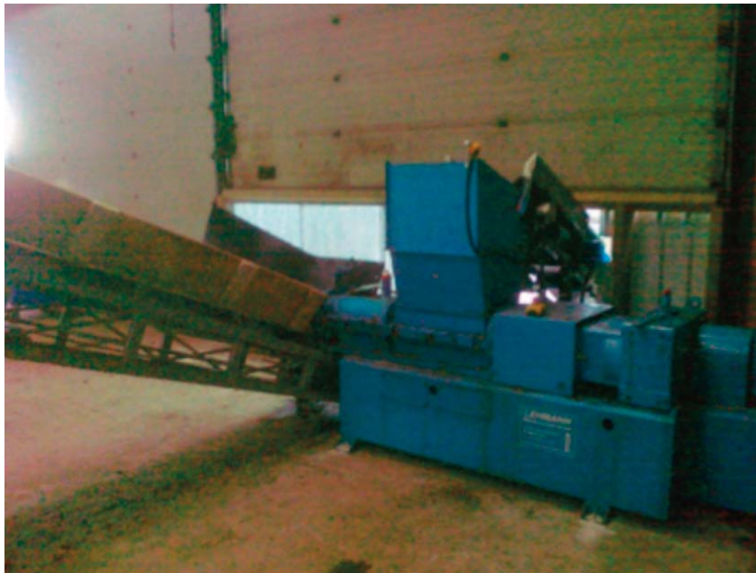
Figuur 4.2 Operationele extruder bij vergistingsinstallatie van JansenWijhe [14].
